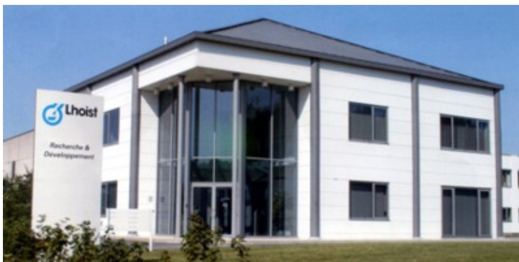
Рисунок 2 - Здание офиса со стенами из газобетонных панелей
